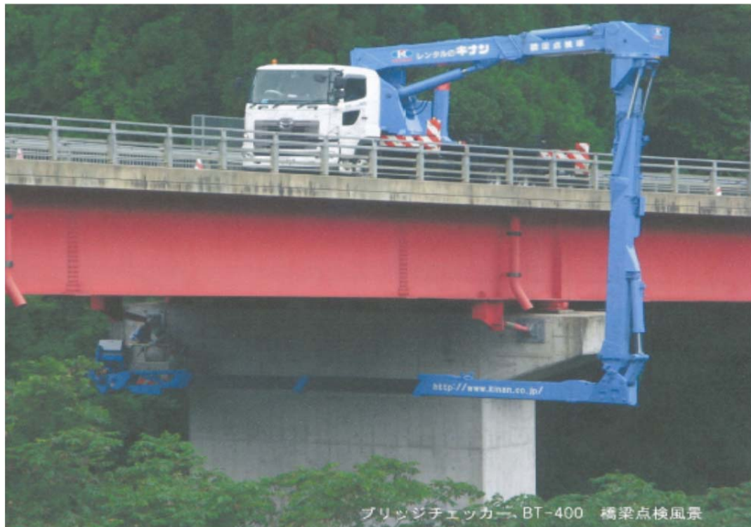
(橋梁点検風景：写真提供－㈱キナン)
