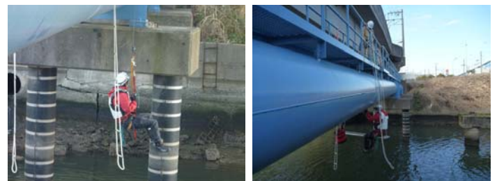
写真－3 橋脚調査状況 写真－4 管体下面調査状況
