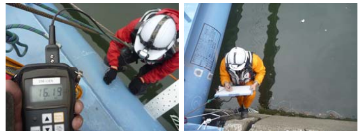
写真－5 管厚測定状況
