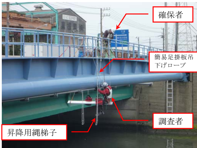
写真－2 調査状況
